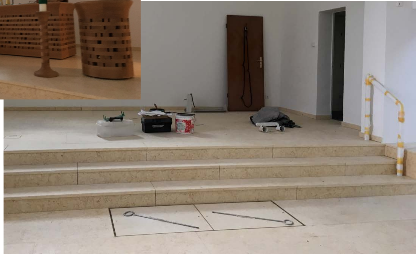
Die Warmluftschächte wurde abgedeckt
