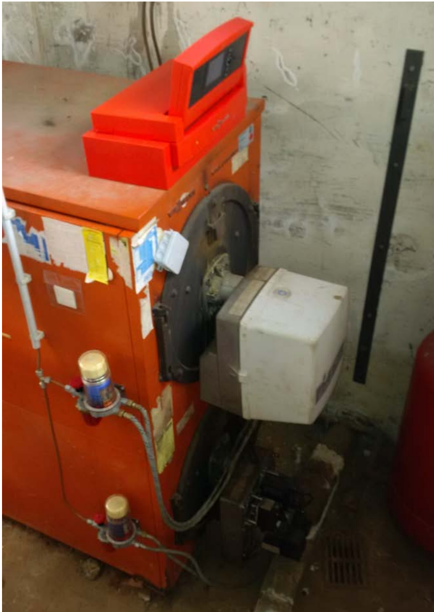
Heizungen Bestand: Ölheizung Bj. 1986 (Ki, GH, PfA) 90 kW mit Warmluft sowie Heizkörper Ölheizung Bj. 1997 (PH) 18 kW mit Heizkörper, Kachelofen mit Holz
